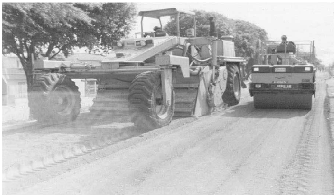
EXECUÇÃO DE RECICLAGEM DE REVESTIMENTO E BASE
