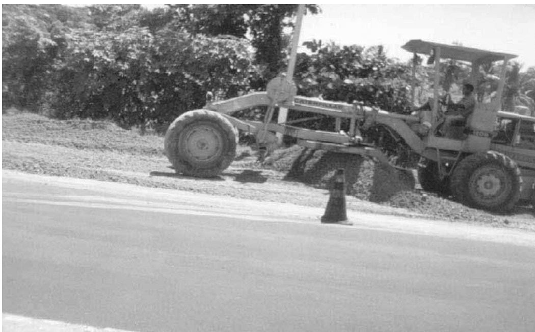
EXECUÇÃO DE BASE COM BRITA GRADUADA
