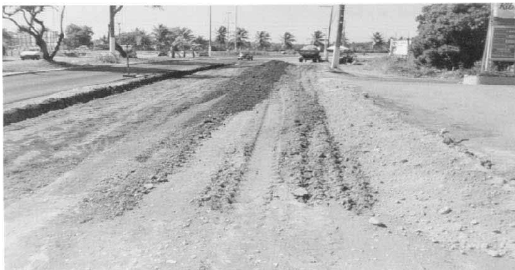
EXECUÇÃO DE SUB-BASE
