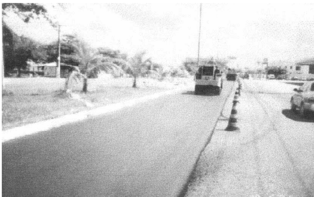
EXECUÇÃO DE REVESTIMENTO COM C.B.U.Q
