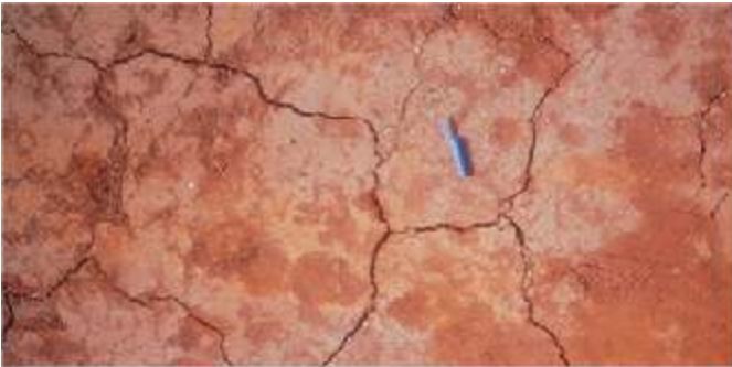
Figura 11 - Trincamento devido à secagem do SAFL - solo argiloso, grupo LG'.
