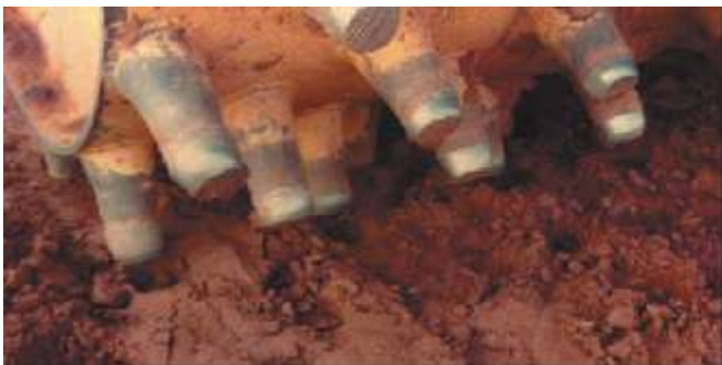
Figura 4 - Início da compactação com rolo pé-de-carneiro de pata longa.
