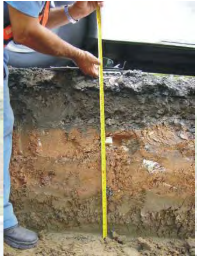
Detalhe do corte da escavação do serviço de remendo profundo, no km 277,9, sentido Campos.
