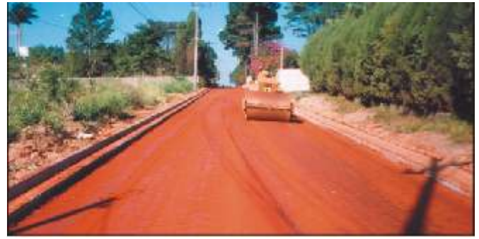
Figura 6 - Complementação da compactação da base intermediária, com rolo de pneus de pressão variável
