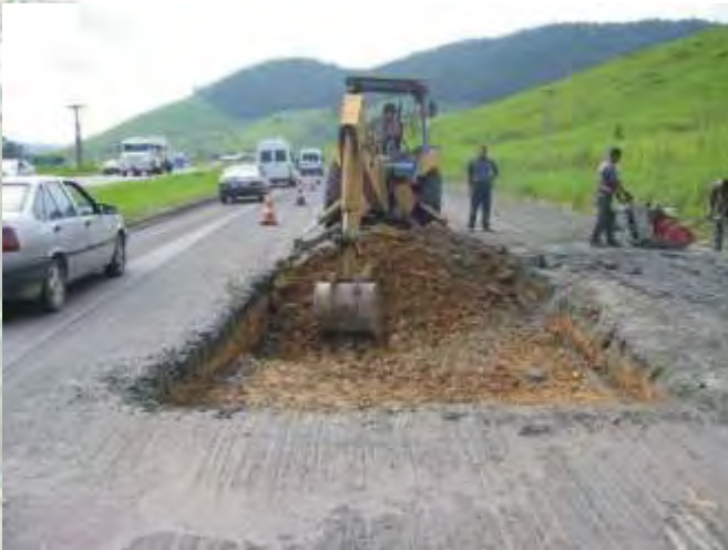
Detalhe do serviço de escavação de remendo profundo, no km 277,9 sentido Campos.
