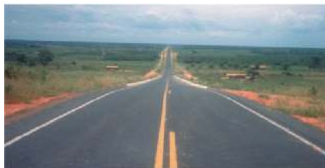
Figura 25 - Vicinal Bahia, executada em 1990.
