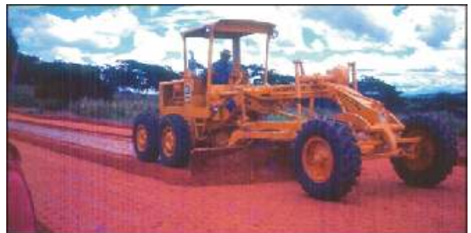
Figura 8 - Acabamento da superfície da base por corte com motoniveladora.
