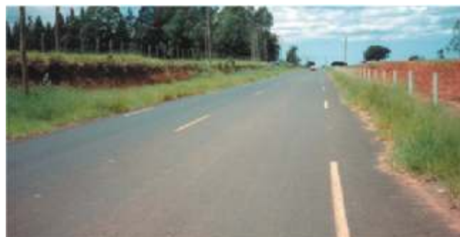
Figura 24 - Vicinal Araraquara-Bueno de Andrade-SP. Executada em 1989. Extensão 20 km.
