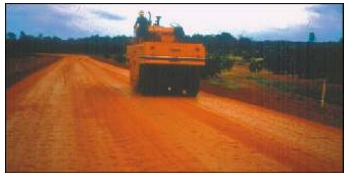
Figura 7 - Complementação da compactação de campo, com rolo liso vibratório.
