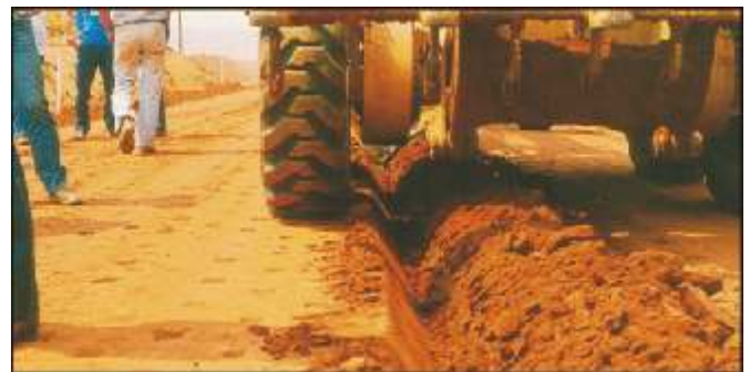
Figura 9 - Acabamento da borda da base por corte.
