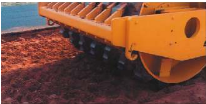
Figura 5 - Compactação intermediária com rolo pé-de-carneiro vibratório pesado.
