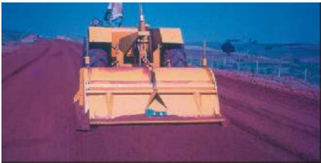
Figura 3 - Pulverização do solo com pulvi-misturadora.
