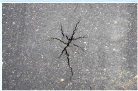
Trinca radial ("Pé-de-galinha" ou "vulcãozinho")
