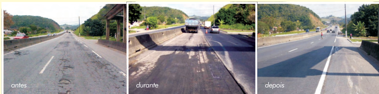
Evolução das obras na BR-101, RJ, sentido Manilha, km 263 – Fotos Engespro.
