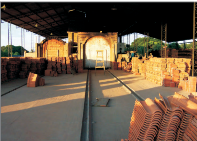
Figura 10 – Vista geral dos dois fornos tipo túnel e do sistema de trilhos para o deslocamento dos vagões.
