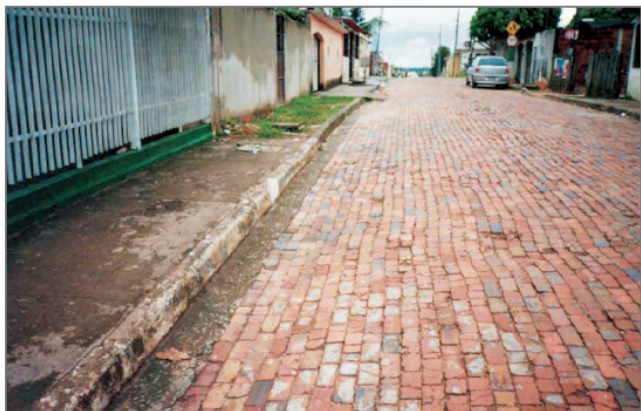
Figura 1 – Pavimentação urbana com o emprego de tijolos cerâmicos em Rio Branco no Acre (Fonte: Ricardo R. do Nascimento).
