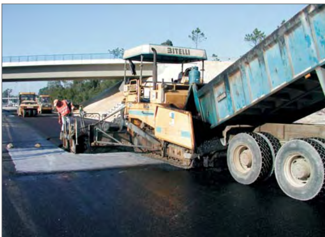
Figura 4 – Aplicação da mistura com reciclagem a quente
