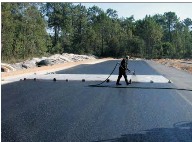
Figura 3 – Aplicação do geotextil
