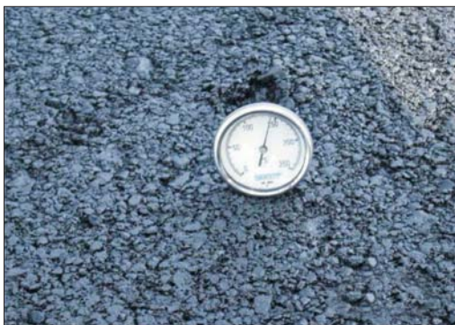
Figura 16: Controle da Temperatura. Obras de Melhorias no Acesso a BR-282/SC em Chapecó/SC.
