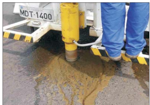
Figura 20: Extração de Corpos-de-Prova da Pista. Obras de Melhorias no Acesso a BR-282/SC em Chapecó/SC.
