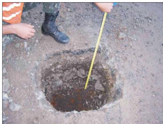
Figura 13: Abertura de Poço de Sondagem. Acesso a BR-282/SC em Chapecó/SC.
