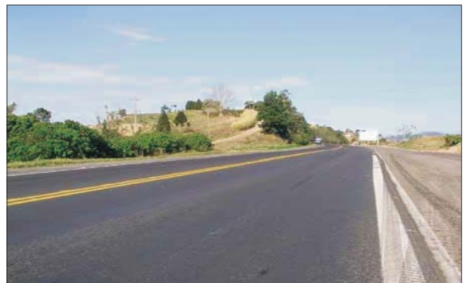
FIGURA 2 – Trecho da BR-116 revestido com asfalto-borracha
