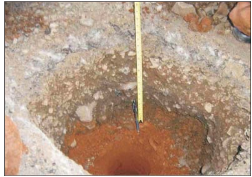
Figura 14: Abertura de Poço de Sondagem. Acesso a BR-282/SC em Chapecó/SC.
