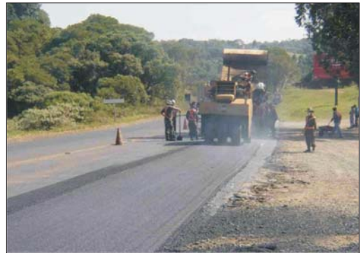
Figura 15: Alargamento da Faixa de Rolamento. Obras de Melhorias no Acesso a BR-282/SC em Chapecó/SC.
