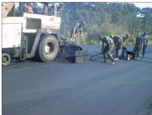
Figura 10: Execução de Revestimento Asfáltico na BR-282 Trecho Lages a São José do Cerrito.
