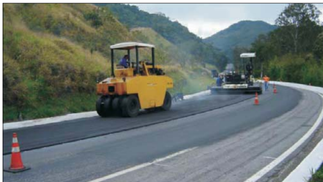
FIGURA 4 – Trecho da BR-040, no Rio de Janeiro, recuperado com asfalto-borracha
