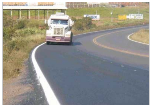
Figura 16: Melhorias no Acesso a BR-282/SC em Chapecó/SC.
