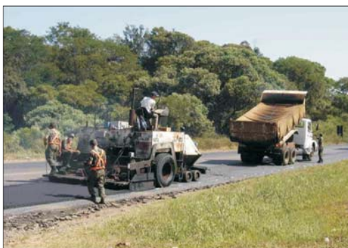
Figura 17: Execução de Novo Revestimento Asfáltico. Obras de Melhorias no Acesso a BR-282/SC em Chapecó/SC.
