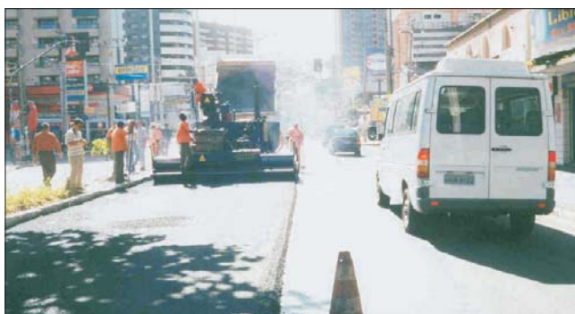
FIGURA 3 – Trecho de via urbana em São Paulo, recuperado com asfalto-borracha
