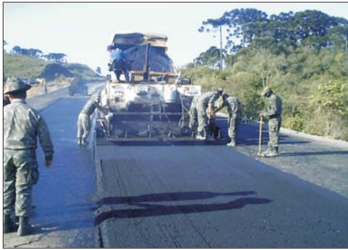
Figura 11: Execução de Revestimento Asfáltico na BR-282 Trecho Lages a São José do Cerrito.
