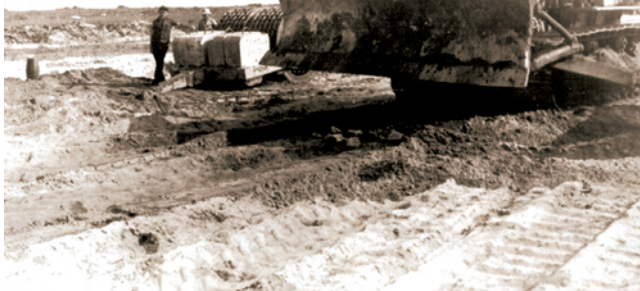
Foto 4 – Trator de esteiras regularizando o subleito
