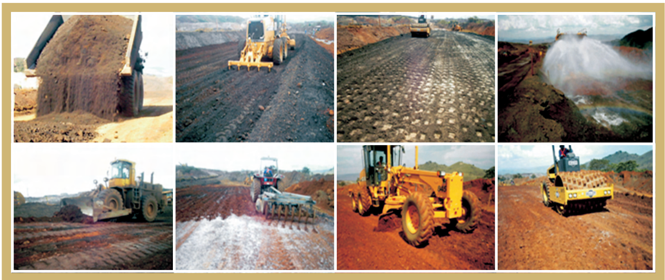
Figura 4 – Algumas etapas da construção do pavimento.
