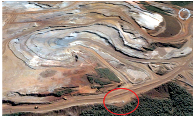
Figura 2 – Detalhe da região de implantação do trecho experimental, preliminarmente à sua execução. (Fonte: Google Earth)
