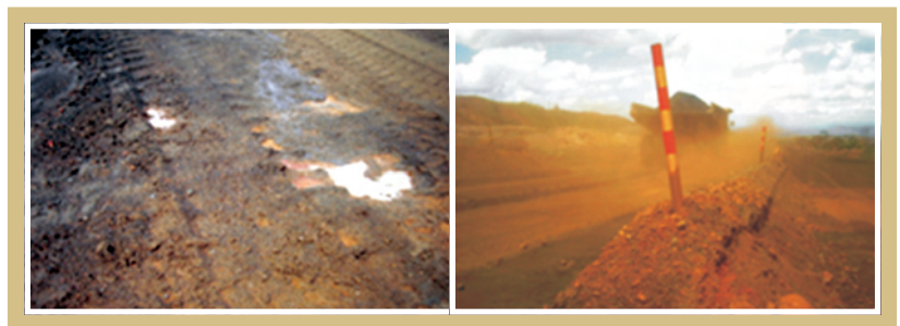
Figura 1 – Exemplos de problemas de drenagem e de geração de pó em estradas de minas a céu aberto.
