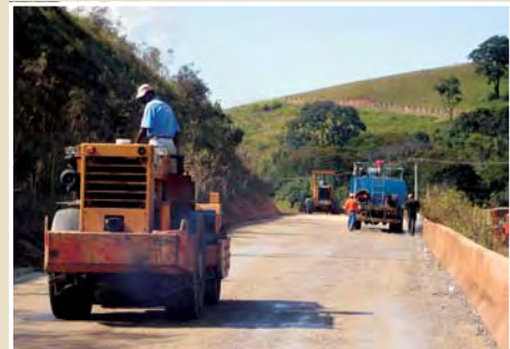
(f) Compactação da base
