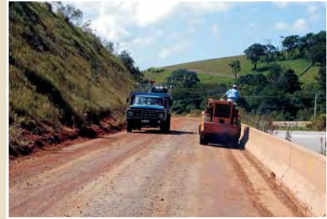
(d) Compactação do subleito
