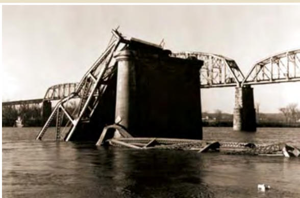
“Silver Bridge”: estrutura em colapso.
