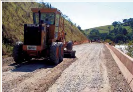
(e) Regularização da base
