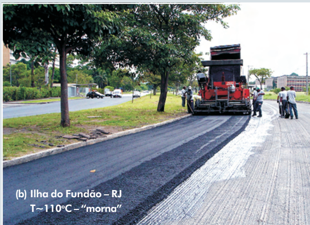
Figura 11 – Comparação entre a compactação de misturas asfálticas em diferentes temperaturas, em termos de emissão de fumos
