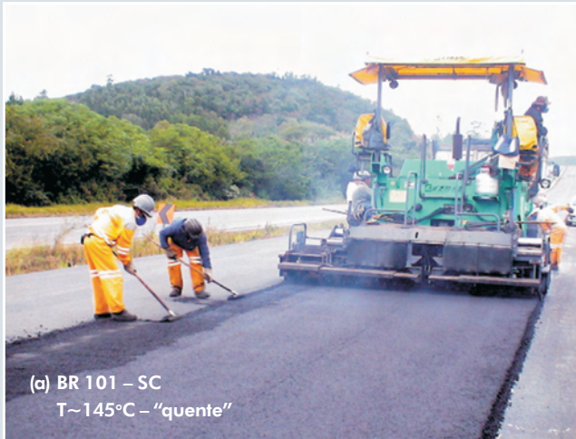
Figura 11 – Comparação entre a compactação de misturas asfálticas em diferentes temperaturas, em termos de emissão de fumos
