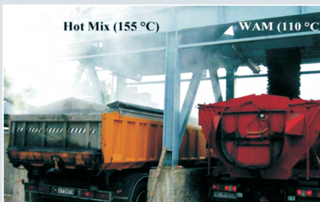
Figura 17 – Usinagens simultâneas: uma na temperatura convencional (155°C) e outra “morna” (110°C)
