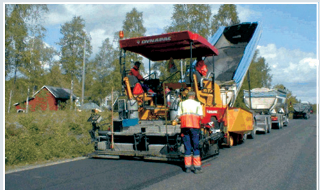
Figura 2 – Exemplos de operação de aplicação de concreto asfáltico com cuidados adequados de SMS
