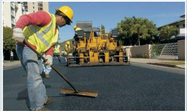
Figura 2 – Exemplos de operação de aplicação de concreto asfáltico com cuidados adequados de SMS
