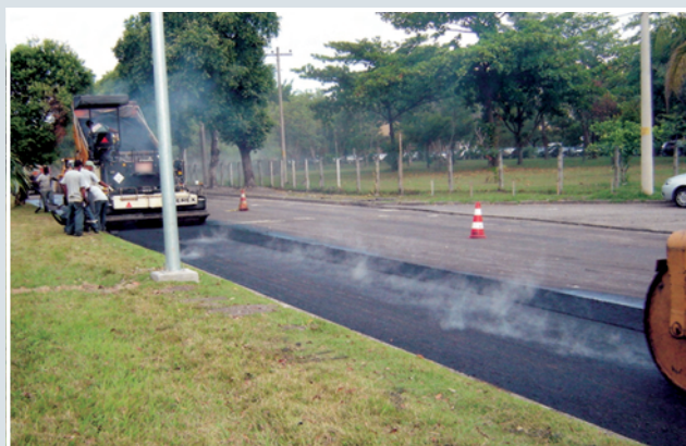
Figura 1 – Exemplos de aplicação de misturas asfálticas a temperaturas que provocam fumos e exposição de operários a estes.
