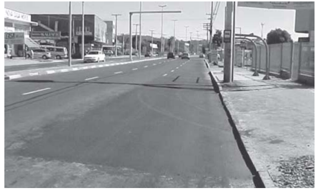
Figura 8 – Exemplo de manutenção corretiva de longa extensão refazendo todo o ponto de ônibus
