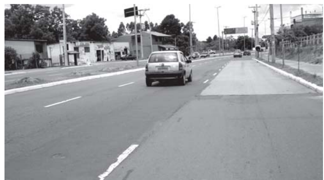
Figura 32 – Manutenção corretiva executada na capa asfáltica anterior à parada de ônibus
