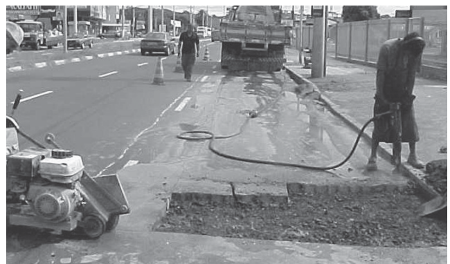
Figura 6 – Exemplo de resíduos gerados nas correções sucessivas no mesmo ponto e poluição sonora dos equipamentos usados
