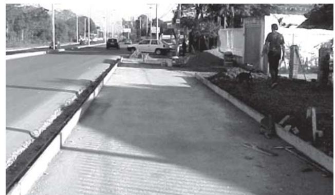
Figura 13 – Colocação das formas
