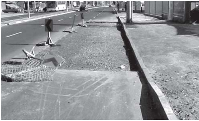
Figura 7 – Aspectos de segurança em pontos de ônibus
