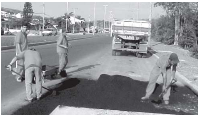
e – Nivelamento da transição
