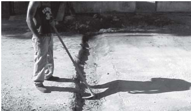
Figura 16 – Detalhe do espessamento da borda
