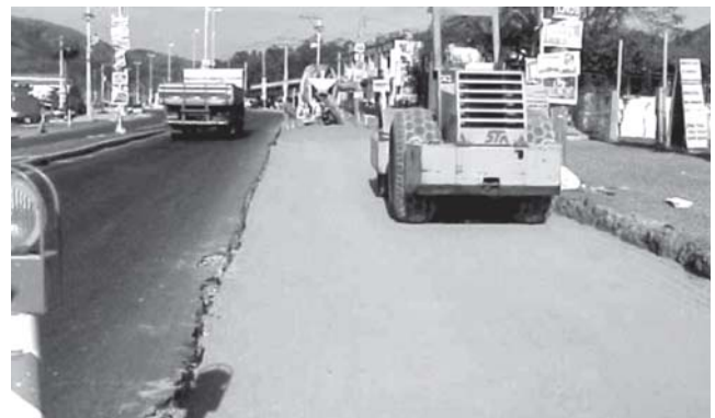
Figura 12 – Sub-base de CCR
