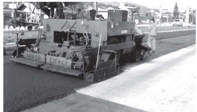
f – Asfaltamento da pista
