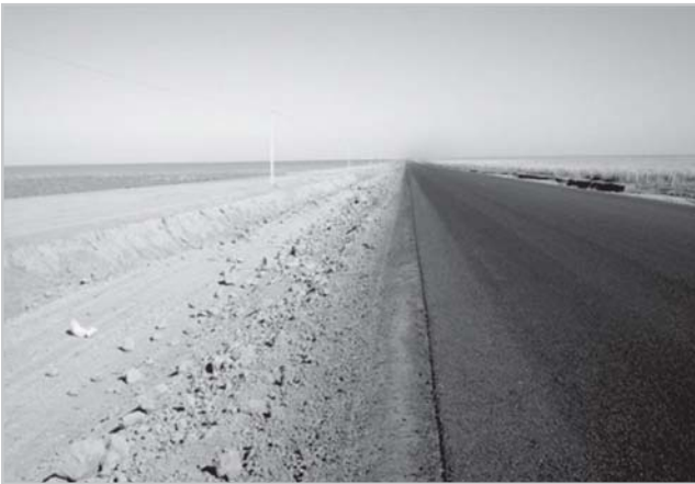
Vista da caixa de acumulação construída no local onde foi tirada a foto 11, na MT-235, subtrecho Campo Novo do Parecis-Rio Papagaio
