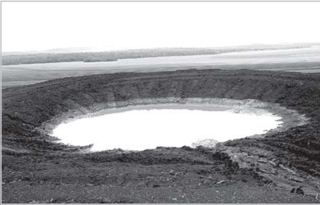
Outra vista da caixa de dispersão construída na Rodovia MT-235, com detalhes do terreno de jusante livre de erosões.
