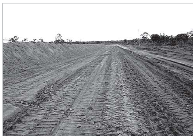
Vista do fundo de uma caixa de acumulação onde foi construído um BDTC Ø 1,00m, com detalhe da altura do aterro para acomodar o bueiro e a caixa escavada na MT-235, subtrecho Campo Novo do Parecis-Rio Papagaio, de acordo com a solução submetida ao IBAMA.
