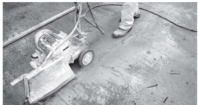
Figura 5 – Serragem das juntas
