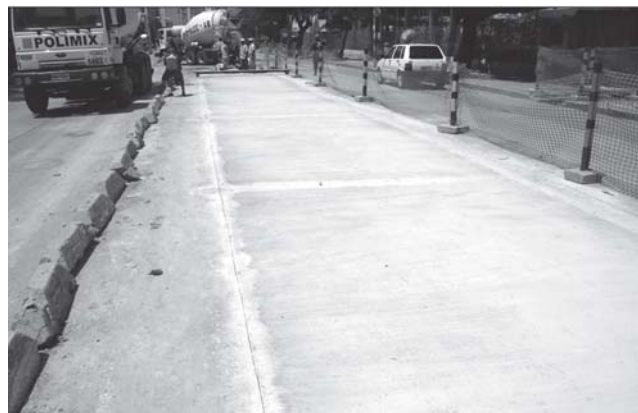
Figura 3 – Ilustração de uma das interdições durante a obra deste estudo – Cura do concreto – (Foto do autor, Maio / 2007)
