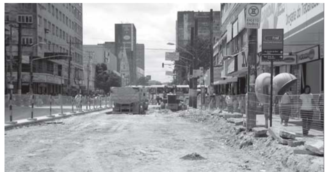
Figura 4 – Subleito após remoção placas antigas
