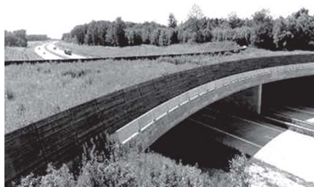
Figura 2 – Ponte ecológica, na Rodovia BR-101 sul (Fonte: PBA – subprograma de proteção à fauna, 2001)
