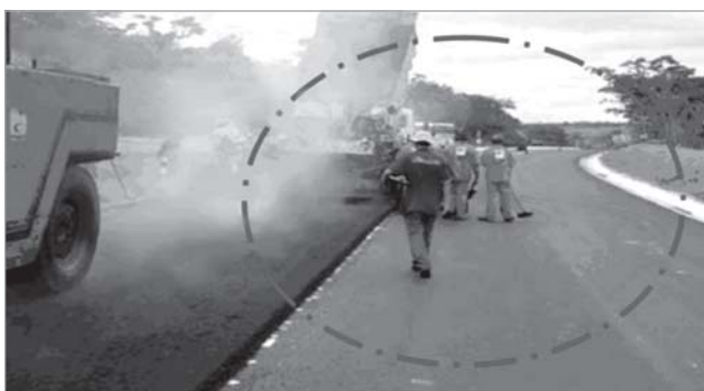
Figura 6: Recapeamento Asfáltico – Fonte: www.1gec.eb.mil.br
