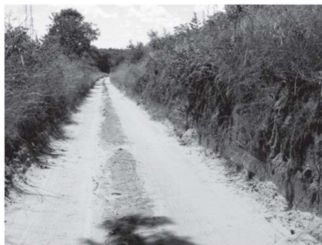
Figura 5 – Vista geral do trecho em seção de corte. (Foto: Wallen Medrado).
