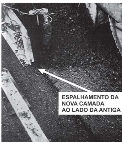
Figura 20 – Exemplo de espalhamento de camada nova contígua à antiga. (Fonte: AASHTO Handbook)
