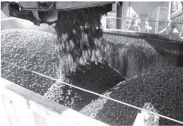
Figura 6 – Forma correta de carregar um caminhão com massa asfáltica na usina. (Fonte: Juan Pablo – Rettenmaier)
