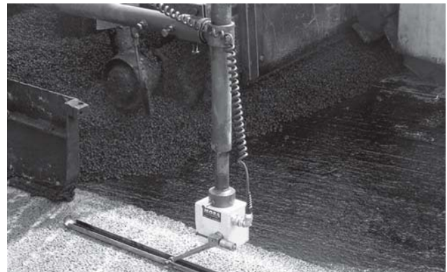
Figura 22 – Controle de espessura e acabamento. (Foto do autor)
