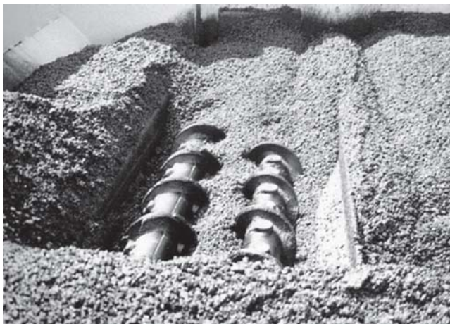
Figura 13 – Uso de misturador na mesa da acabadora. (FONTE: ASTEC - TP 134)
