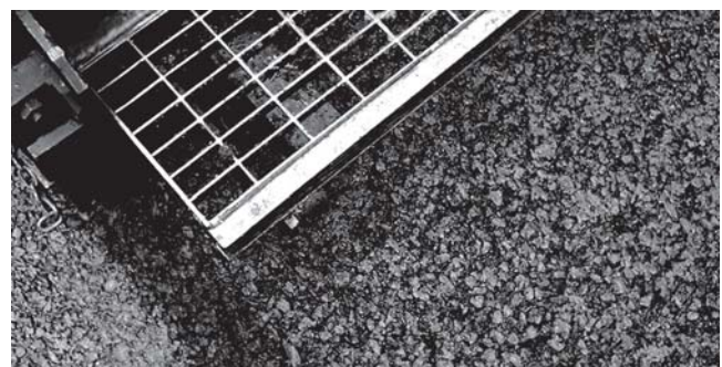
Figura 24 – Espalhamento da massa e controle do acabamento: observar o empolamento na junta (Foto do autor)
