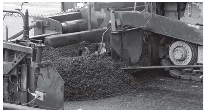
Figura 23 – Espalhamento da massa. (Foto do autor)
