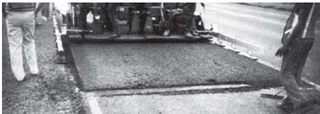
Figura 18 – Rastelamento adequado na distribuição da massa asfáltica. (Fonte: AASHTO Handbook)
