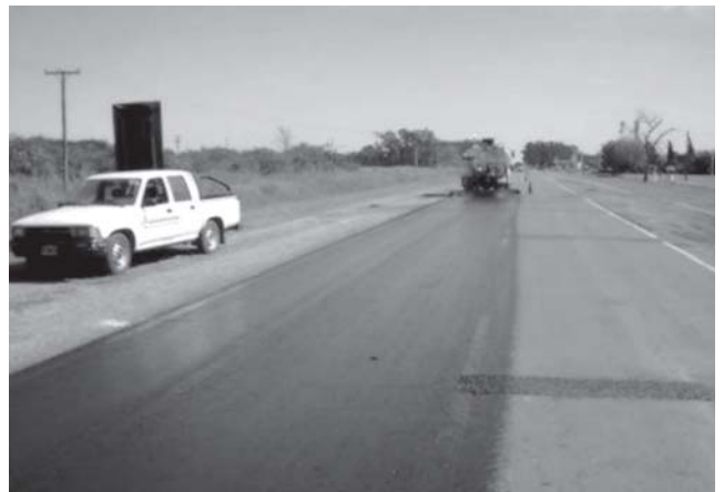
Figura 8 – Cuidados na pintura de ligação – uso adequado de barra espargidora (Foto do autor)
