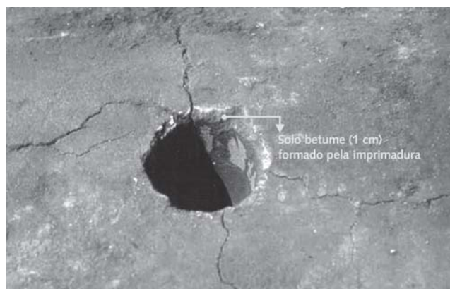
Figura A.10 – Aspecto de uma penetração adequada da imprimadura, com formação do solo betume na superfície da base.
