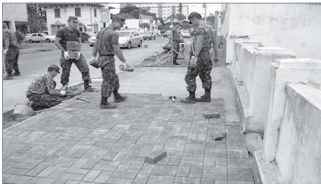
Figura 4 – Execução de pavimentação com as peças de concreto com ADF no entorno do 62º Batalhão de Infantaria de Joinville.
