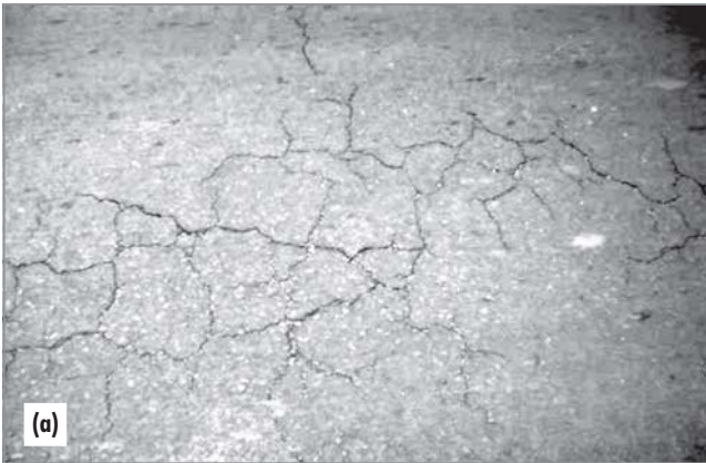
Figura 9 – Defeito trincas couro de crocodilo de baixa severidade, presente na seção 4 (a); e de alta severidade, presente na seção 7 (b)
