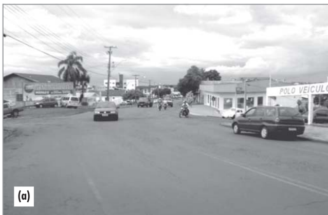
Figura 7 – Foto da seção 3 do Trecho 1, classificação do pavimento PCI Ruim (a); foto da seção 8 do Trecho 2, classificação do pavimento PCI Regular (b)
