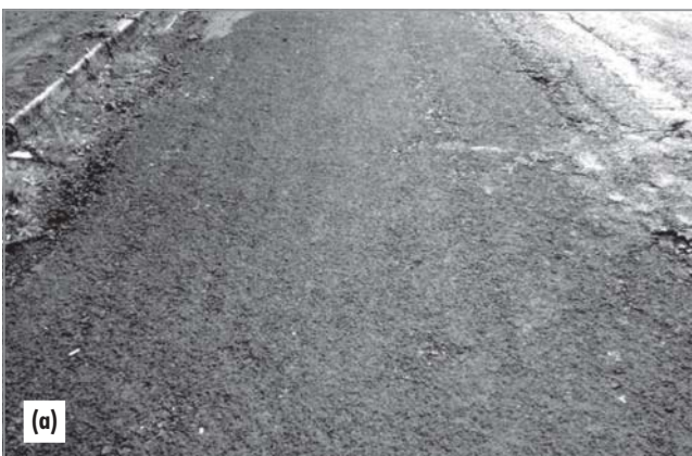
Figura 11 – Desgaste de média severidade, presente na seção 10 (a); e alta severidade, presente na seção 4 (b)
