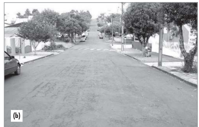
Figura 7 – Foto da seção 3 do Trecho 1, classificação do pavimento PCI Ruim (a); foto da seção 8 do Trecho 2, classificação do pavimento PCI Regular (b)
