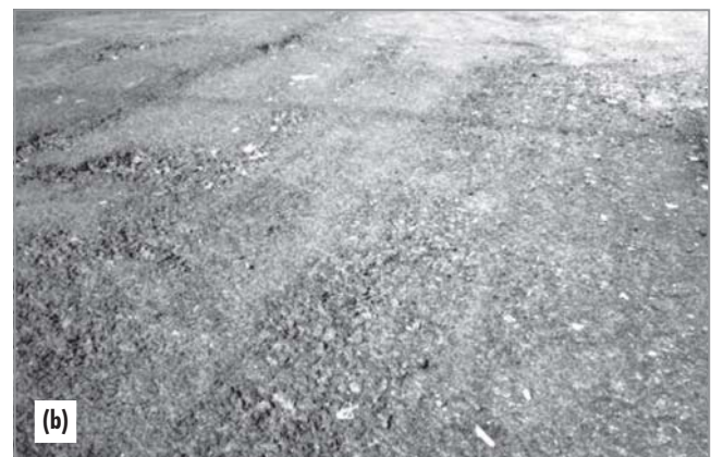
Figura 11 – Desgaste de média severidade, presente na seção 10 (a); e alta severidade, presente na seção 4 (b)
