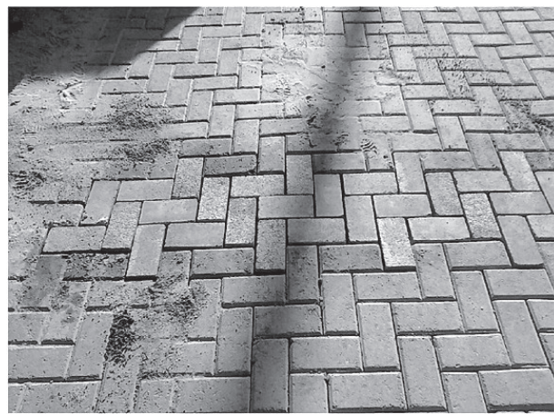
Figura 13 – Aplicação das Peças Fotocatalíticas em Campo.
