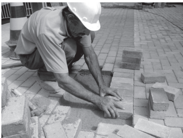
Figura 13 – Aplicação das Peças Fotocatalíticas em Campo.
