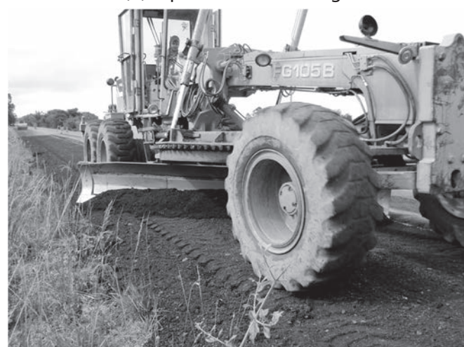
(c) Regularização da camada e revolvimento
