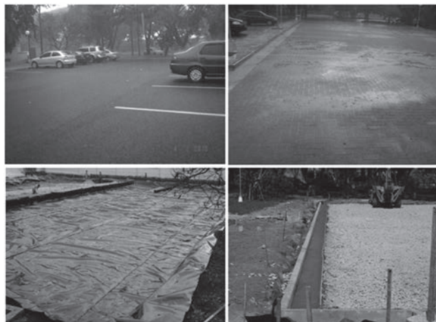
Figura 1- Pavimento permeável com revestimento de concreto poroso asfáltico e blocos de concreto permeável, e detalhes de execução. Fonte: Acervos de Liliane L. C.A Pinto e de Afonso de Virgiliis
