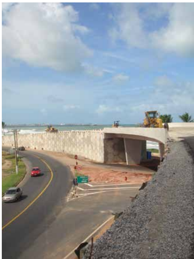
Viaduto do DETRAN (durante a construção) - Foto Georgina Libório
