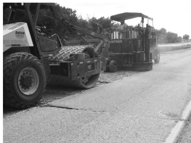
Figura 1 – Execução da fragmentação de um pavimento rígido
