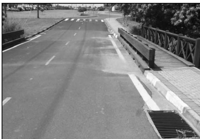
Figura 7 – Estado atual do revestimento da ponte com geogrelha no campus II da USP
