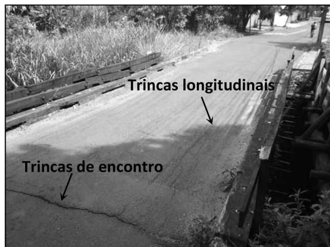
Figura 1 – Ponte sobre o Rio Monjolinho em São Carlos-SP
