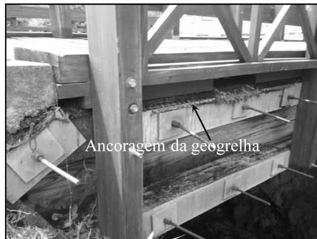
Figura 8 – Detalhe da geogrelha instalada na ponte do campus II da USP, em São Carlos
