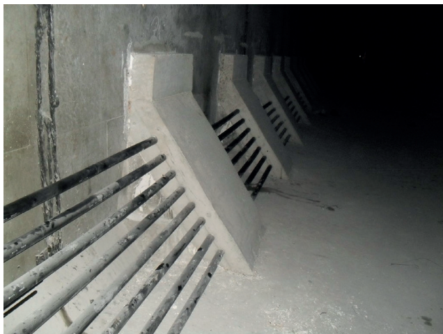
Reforço da superestrutura em aduelas com cabos protendidos adicionais, visando repor as perdas de força da cablagem original de relaxação normal.
