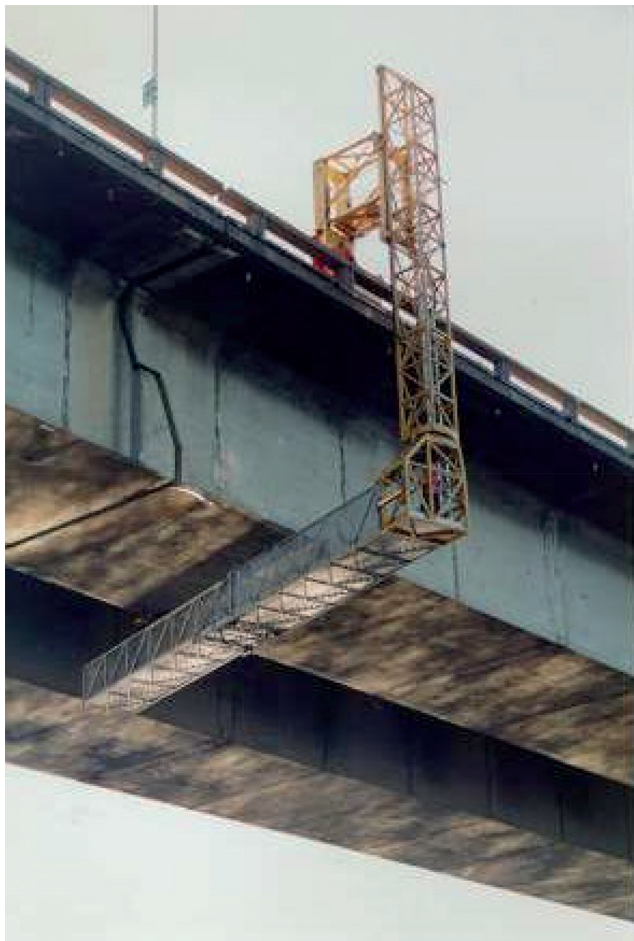
Equipamento Moog para vistoria da ponte em sua parte externa.
