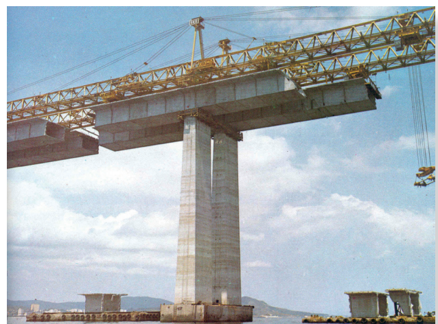
Montagem de aduelas formadora da superestrutura do Trecho sobre o Mar.
