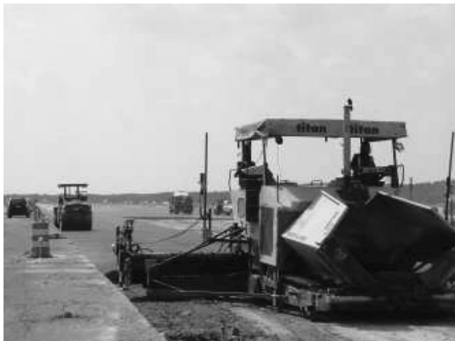
Figura 1 – Construção de base em concreto asfáltico para apoio do novo pavimento de concreto simples no Aeroporto Internacional de Dulles, Washington D.C., em 2004 (fonte: Metropolitan Washington Airports Authority)
