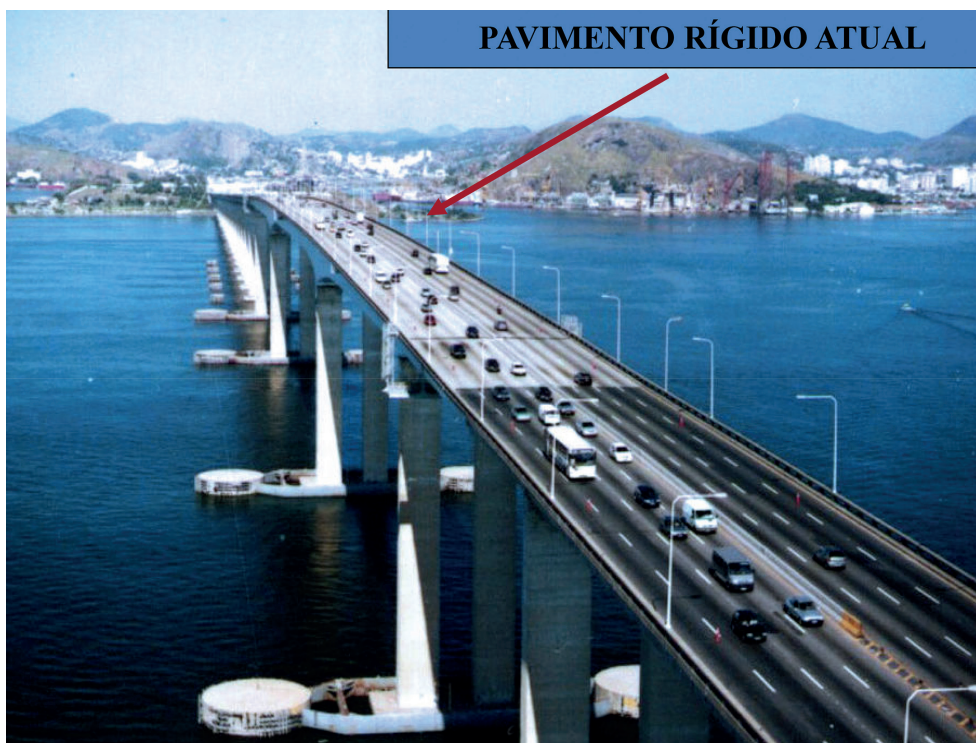
Pavimento em concreto armado nas duas direções sobre os vãos metálicos, notando-se a diferença de coloração com a pavimentação asfáltica dos vãos em concreto.
