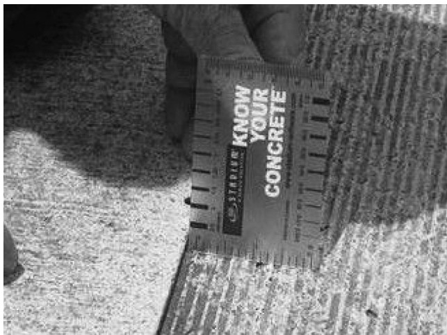
Figura 2 – Redução de espessura de 8 mm na superfície do concreto em rodovia federal, após sua construção, por cepilhamento, para a correção de irregularidade excessiva (acervo pessoal)
