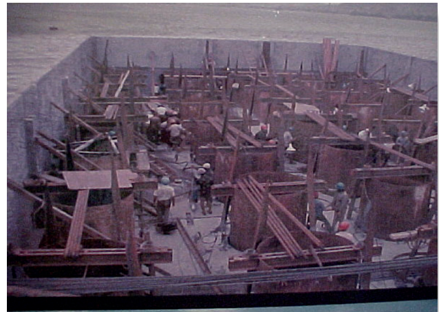
Etapa construtiva de um bloco de fundação no Trecho sobre o Mar.
