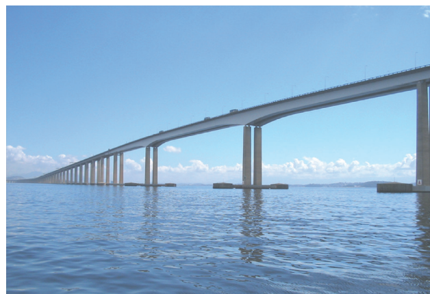
Visão especial dos vãos centrais formados por estruturas metálicas.
