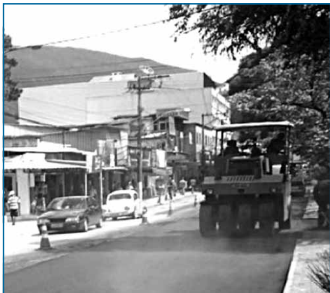
Figura 2. Aplicação de asfalto e emissões de vapores
