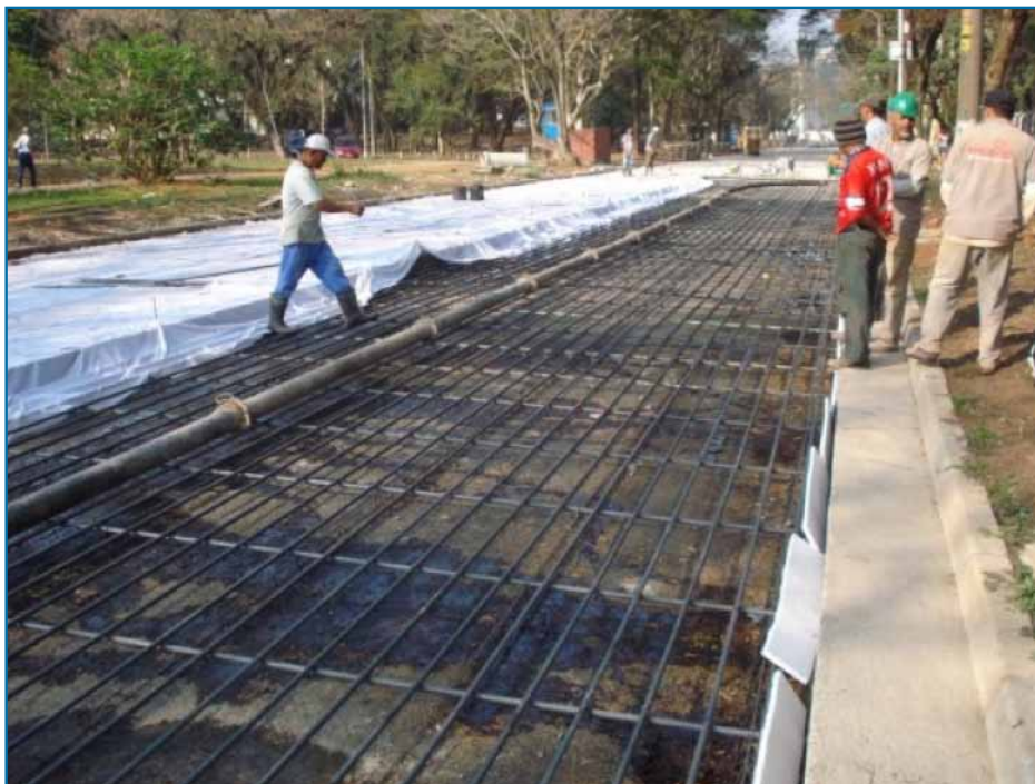
Figura 1 – Detalhe da armadura longitudinal nas seções experimentais
