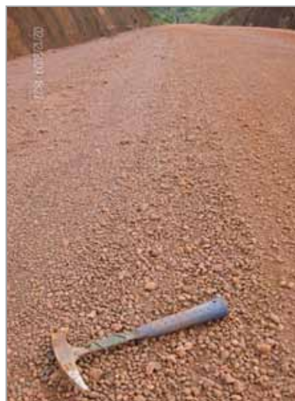
Figura 11: Revestimento primário constituído de laterita de São Gabriel da Cachoeira/AM. Rodovia BR-307/AM, Km 100.
