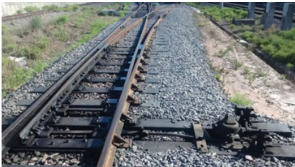
Figura 04 - AMV 1:10 em bitola métrica, montado com dormentes poliméricos Linha Sul Diesel, outubro/2014.
