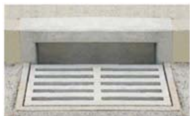
Figura 4 - Caixa coletora com bocas e caixa fabricadas em concreto – tipo B de Belo Horizonte/MG
