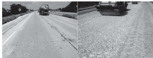
Figura 11 – a) Aspecto do pavimento rígido antes da fragmentação; b) Aspecto visual da placa após a fragmentação.
