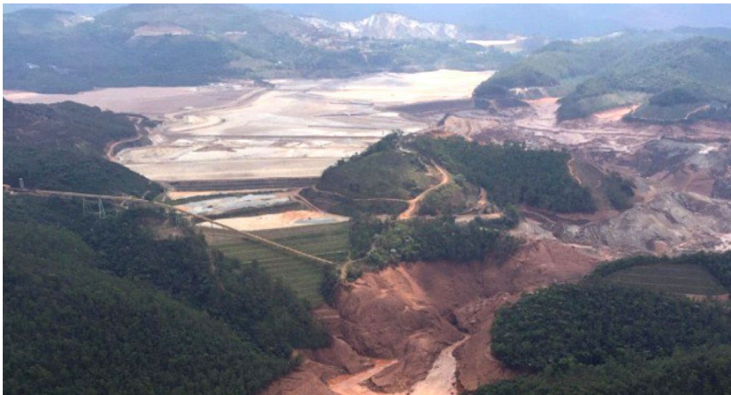
Figura 1 - Depósito de resíduo de minério de ferro Mariana/MG.
