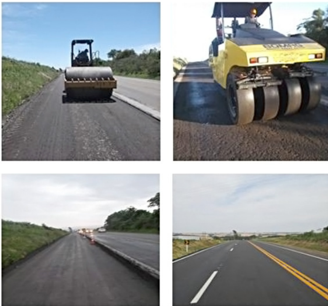
Figura 3 - Relatório fotográfico da execução
