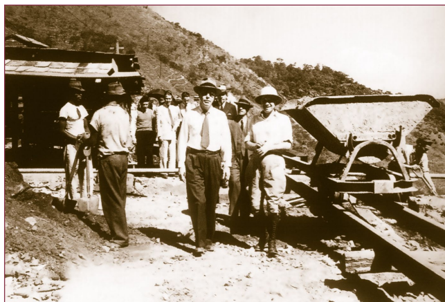
Visita às obras da Serra do Mar - Estrada de Ferro Central do Brasil - 29/04/1944. Em primeiro plano o Engenheiro Edison Passos.
