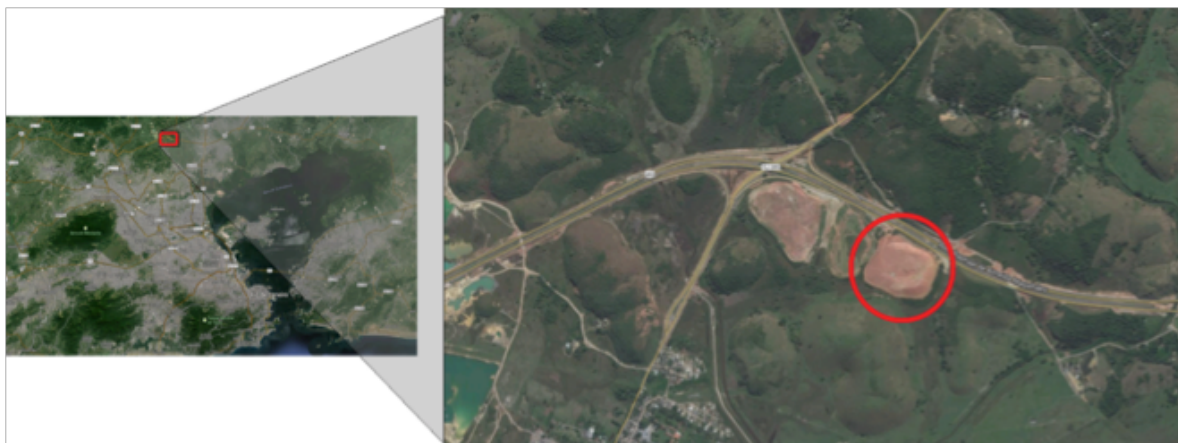
Figura 1 - Localização e detalhe da jazida onde foram retirados os solos desta pesquisa
