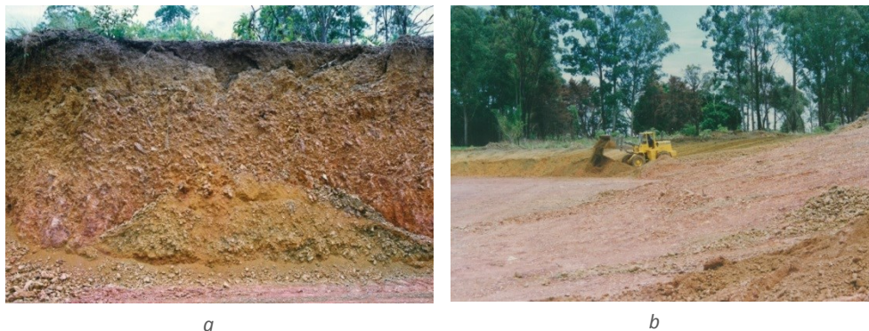
Figura 11 - Jazida de solo típico de granulação grossa de concreção laterítica (Brasília/DF): a) Aspecto da camada a ser explorada; b) Jazida em exploração.
