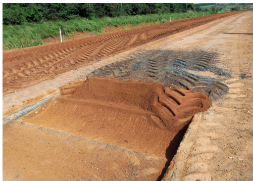
Figura 3 – Materiais extraídos do pavimento
