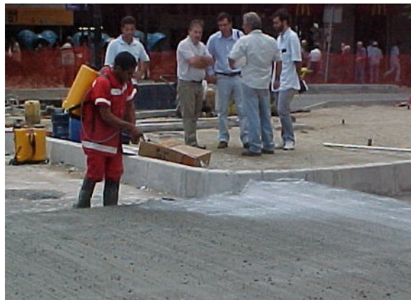
Figura 13: Cura do concreto
