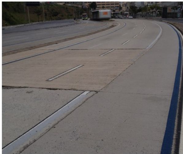
Figura 15 B: Detalhe recuperação pavimento
