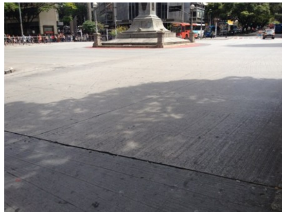
Figura 14 B: Detalhe - juntas e ranhuras da pista
