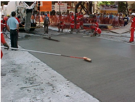
Figura 12: Acabamento superficial final
