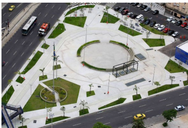
Figura 7 – Reservatório de detenção fechado
