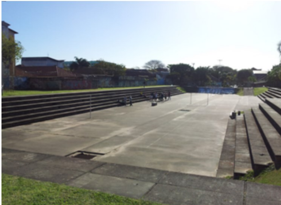
Figura 5 – Reservatório de detenção aberto5.
