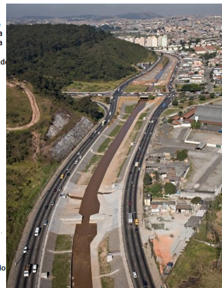
Figura 17 – Reservatório de condução
