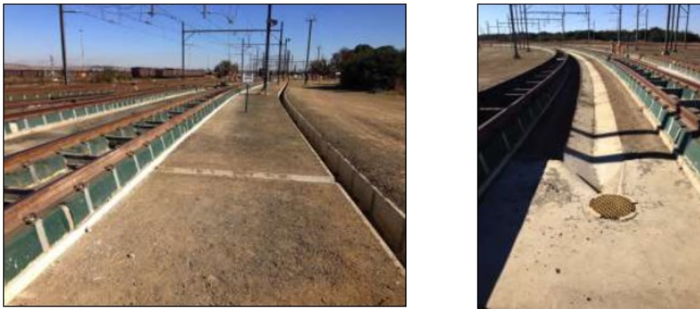
Fig. 8 – Detalhes de drenagem superficial (Pátio de Ermelo (4.8))
