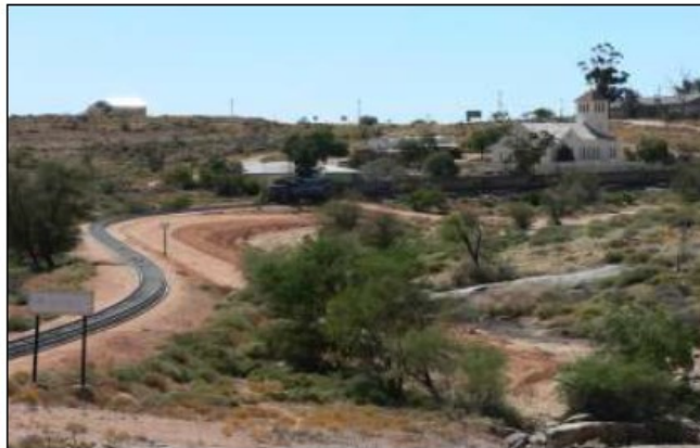
Fig. 1 – Trecho Aus – Lüderitz (Namíbia). Linha de carga reabilitada com Tubular Track (4.1)
