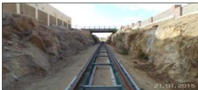
Fig. 12 – Módulos e trilhos instalados num corte em caixão.
