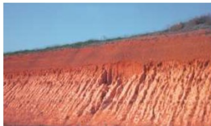
Figura 10- Talude com presença de camadas de solo laterítico (superior) e não laterítico (inferior)
