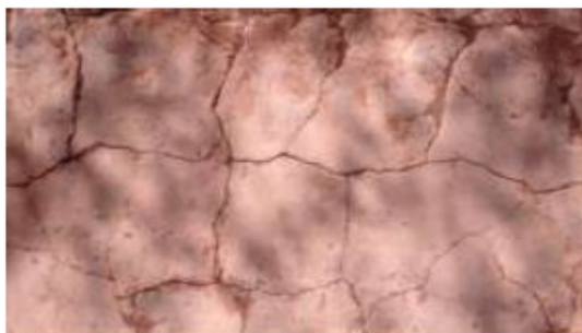
Figura 5- Aspecto do leito de uma estrada implantada constituída de solo LA'
