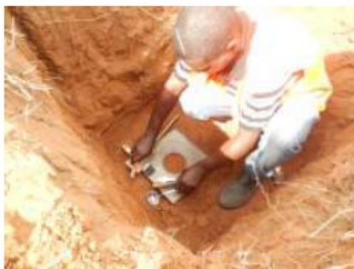
Figura 22- Abertura e preparo da base da cava
