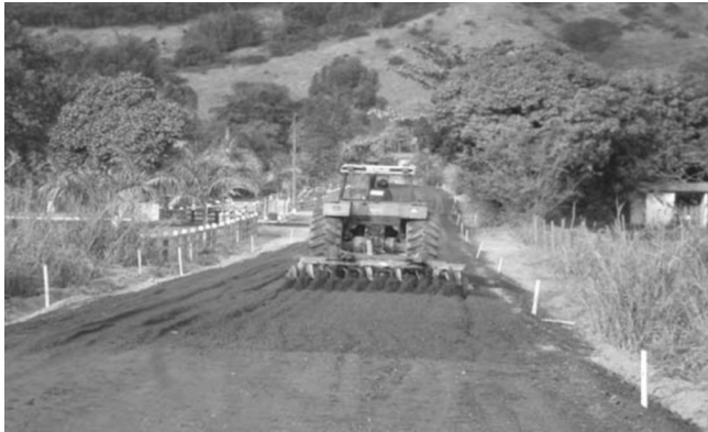
Figura 1 – Confeção da camada de base em escória de aciaria - MG-232 - Mesquita - Santana do Paraíso - Est. 46 (DER/MG, 2006)
