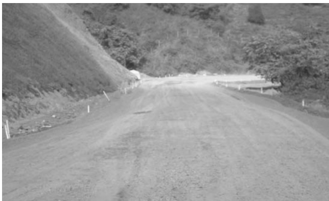
Figura 2 - Base de escória + 20% de argila em execução - MG-232 - Mesquita -Santana do Paraíso - est. 424 (DER/MG, 2007).
