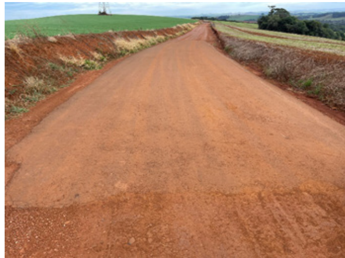
a) Base sem tratamento e revestimento asfáltico com CBUQ faixa “C”.
