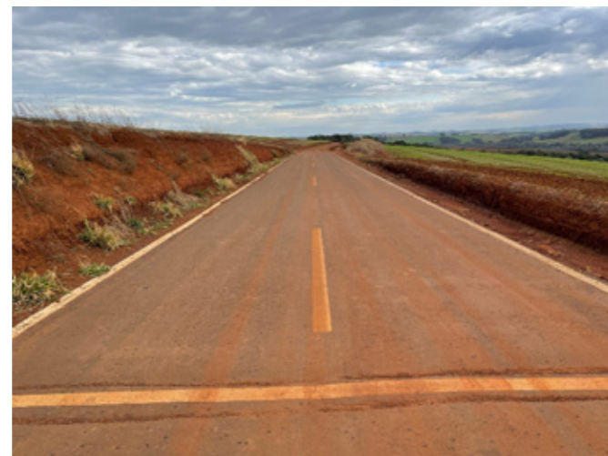
d) Base tratada com o produto e revestimento de CBUQ faixa “C”.
