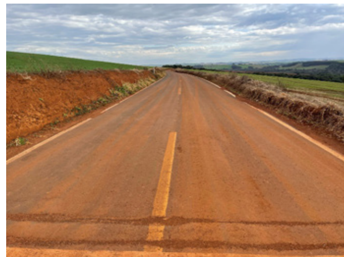
c) Base tratada com o produto e revestimento de CBUQ faixa “F”.
