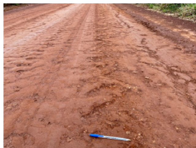
(a) Desgaste e trilhas de roda. Solo com tratamento.
