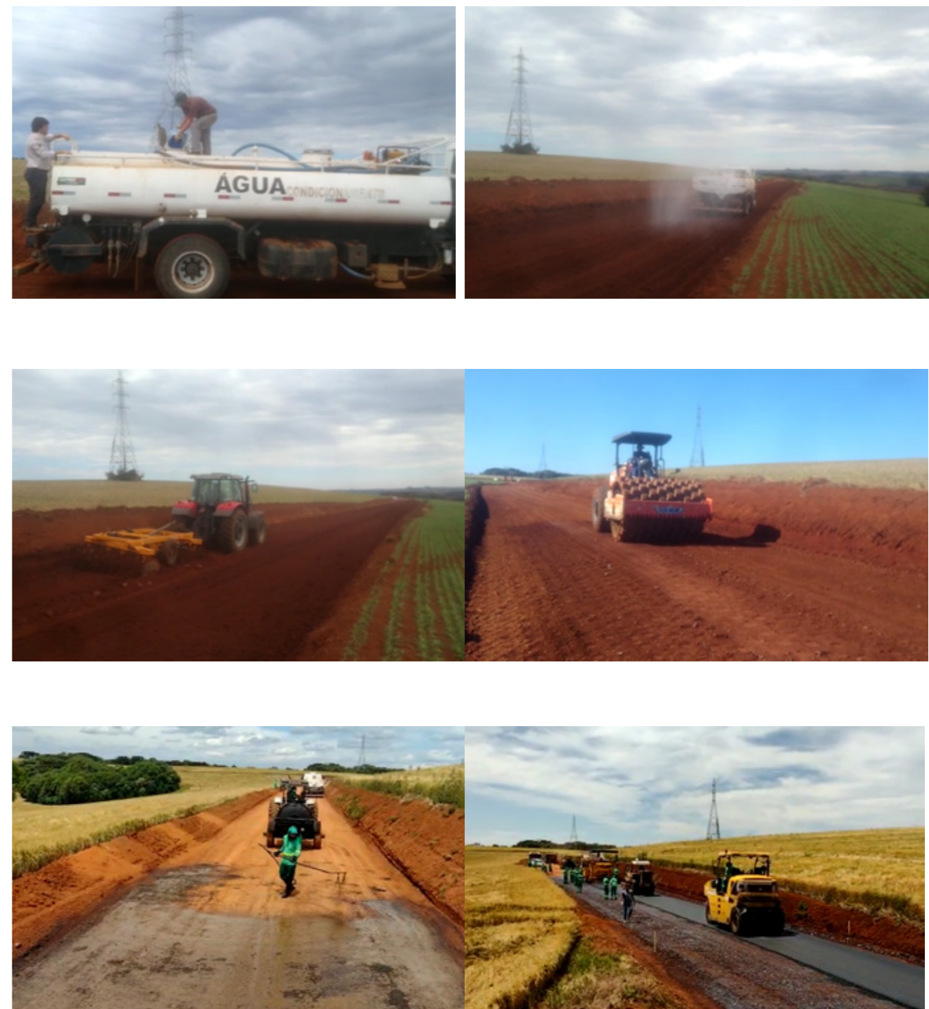
Figura 3: Fotografias da etapa construtiva dos segmentos experimentais. (Fonte: Bemben, 2021).
