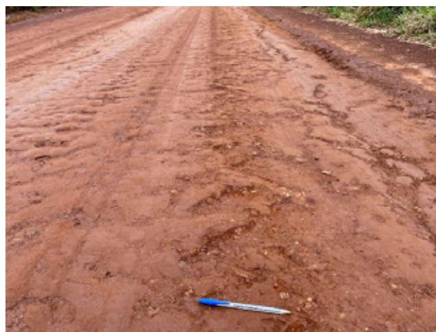
(a) Desgaste e trilhas de roda. Solo com tratamento.
