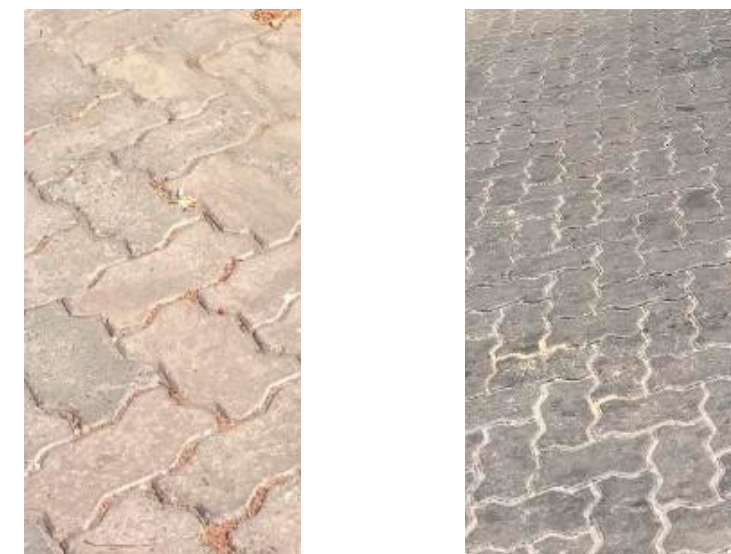
(a) PI de coloração mais clara (b) PI de coloração mais escura Figura 6. Comparativo de cor entre dois trechos em pavimentos intertravados (Autor, 2025)
